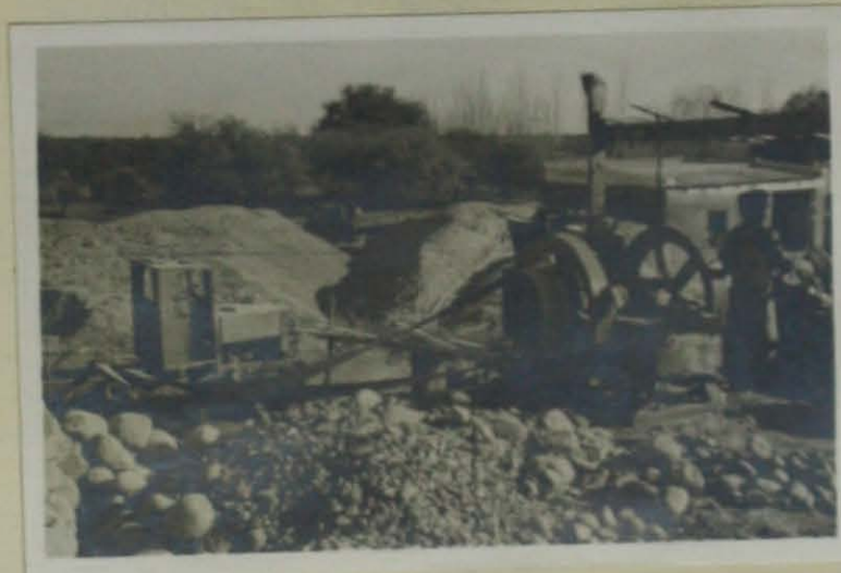
2.-Detalle de las instalaciones.-
