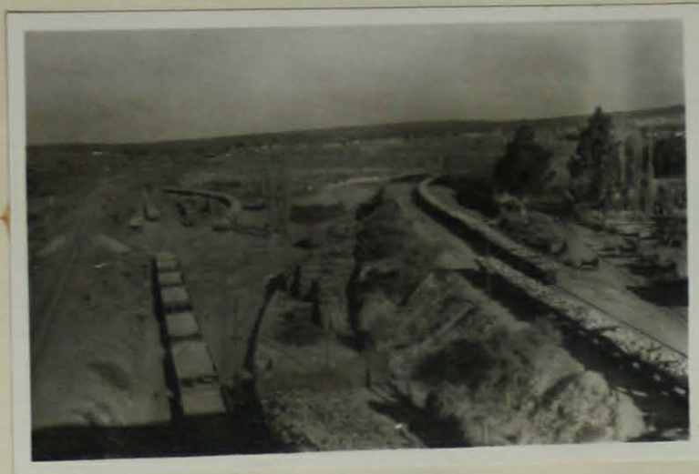
2.-Desvío ferroviario a la planta cantera "Del Estado".-
