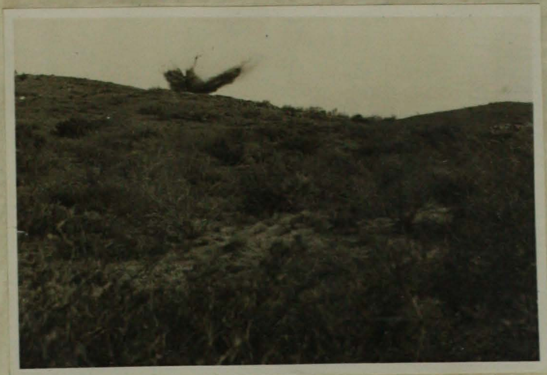
Fotog. 1.- Voladura de 7 tiros durante la apertura de labor 5.
