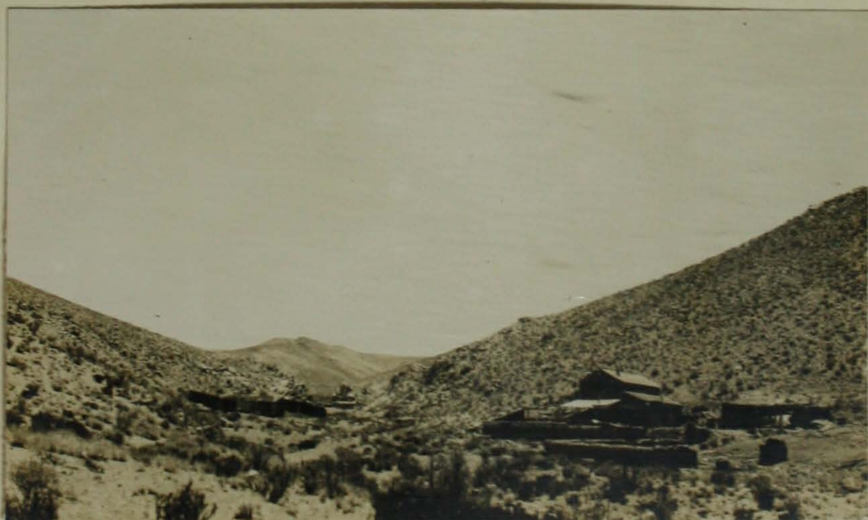
6.- LEONCITO - Vista general de la antigua planta de beneficiación.
