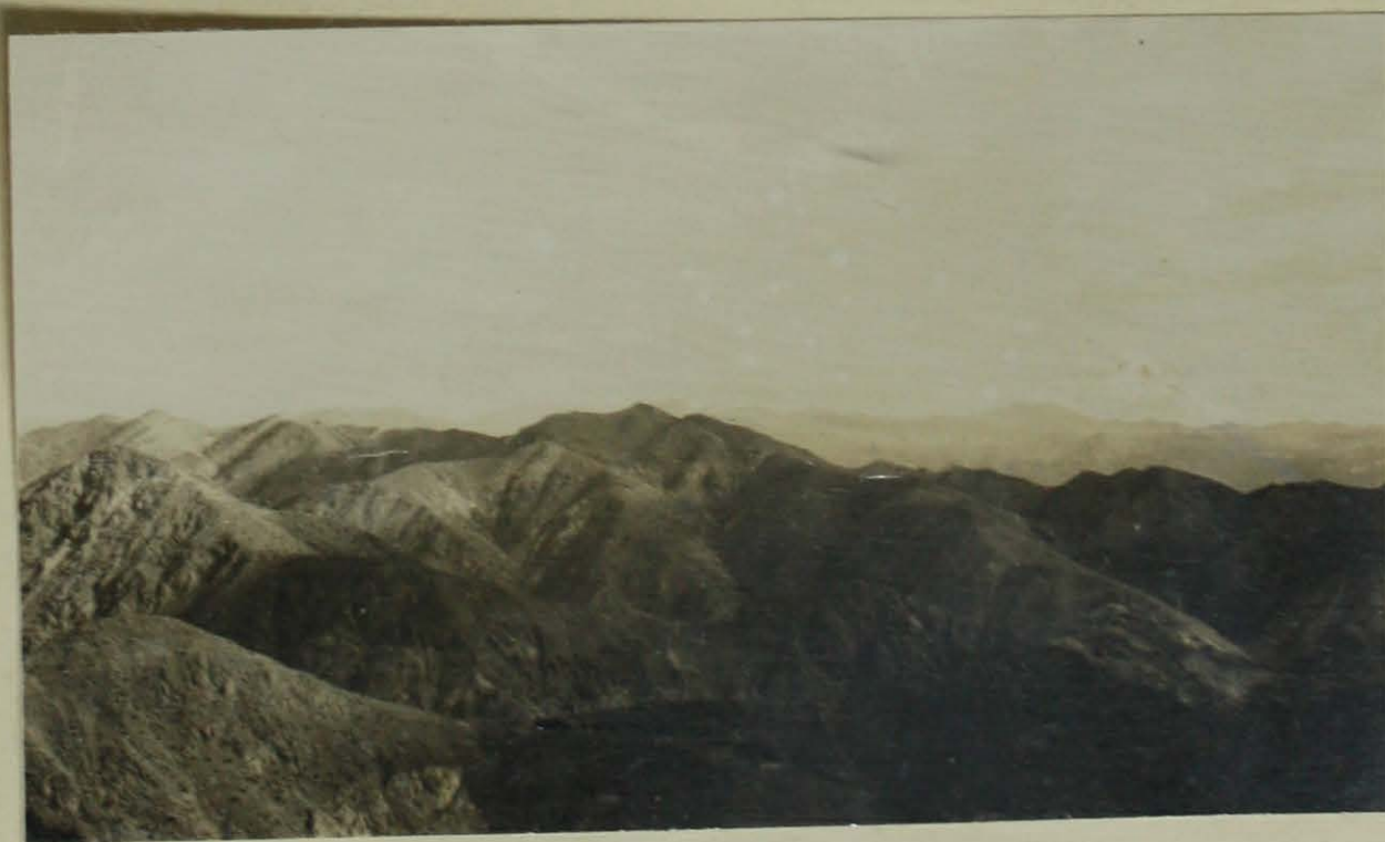
2.- CASTANO VIEJO - Vista de las labores a cielo abierto en la veta "San Nicolás".
