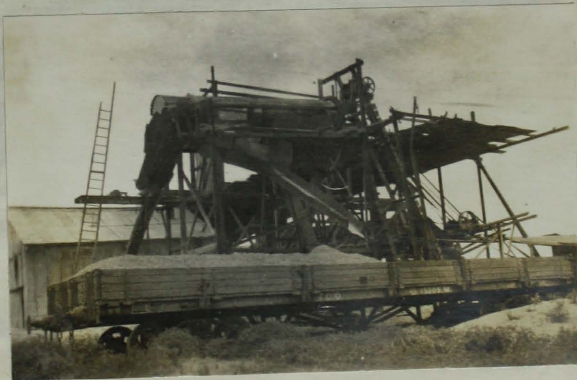
Fotografía nº 2-Cantera "Aguas Blancas"-Planta de molienda y puente de carga.-
