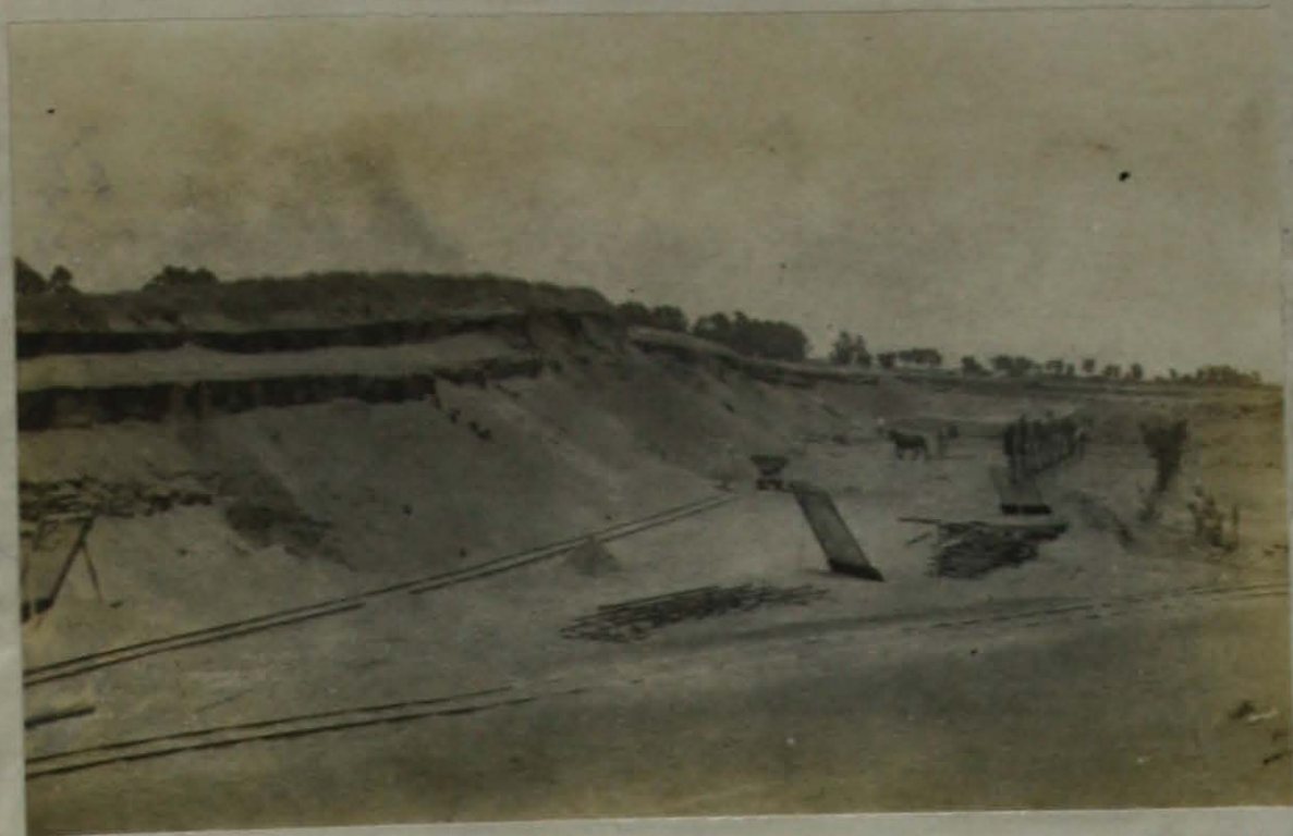
Fotografía nº 1-Cantera "Puerto Belgrano"-Frente de explotación.-
