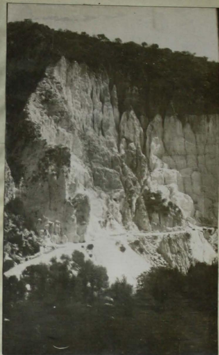
Vistas de la sección central del frente de ataque principal, en donde se puede observar una porción diferenciada correspondiente a un material ferrífero, con el cual se ha hecho un ensayo satisfactorio para la fabricación de ladrillos crudos empleados en diversas fundaciones.
