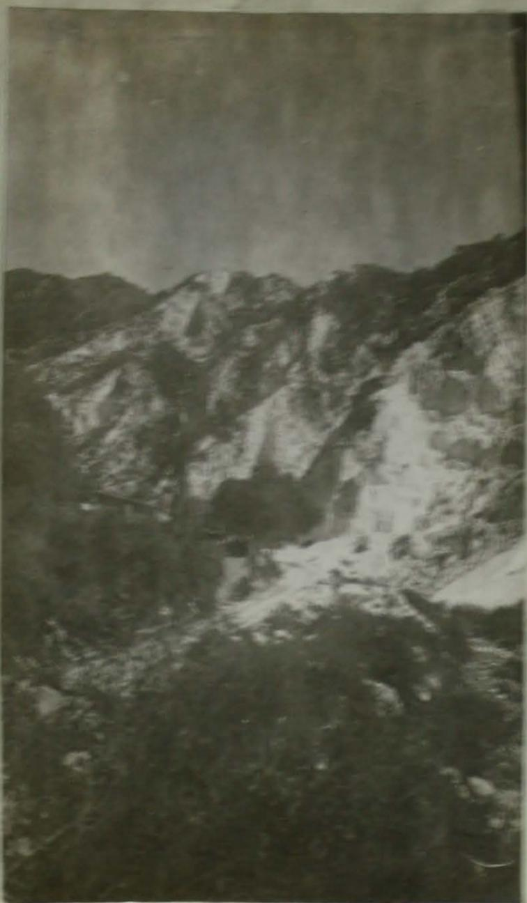
Vista parcial de la sección sud del frente de ataque principal, de donde se extrae el material cuarzo-coalínico proveniente de la meteorización de la roca madre (pegmatita). Este frente principal mira hacia el Este. Se observa a la izquierda de la fotografía, parte del edificio en donde está situada la planta de elaboración. A la derecha de la misma y al centro de la fotografía se ve el camino de acceso al yacimiento.
